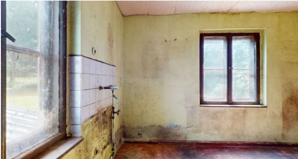
ehemalige Küche im EG
