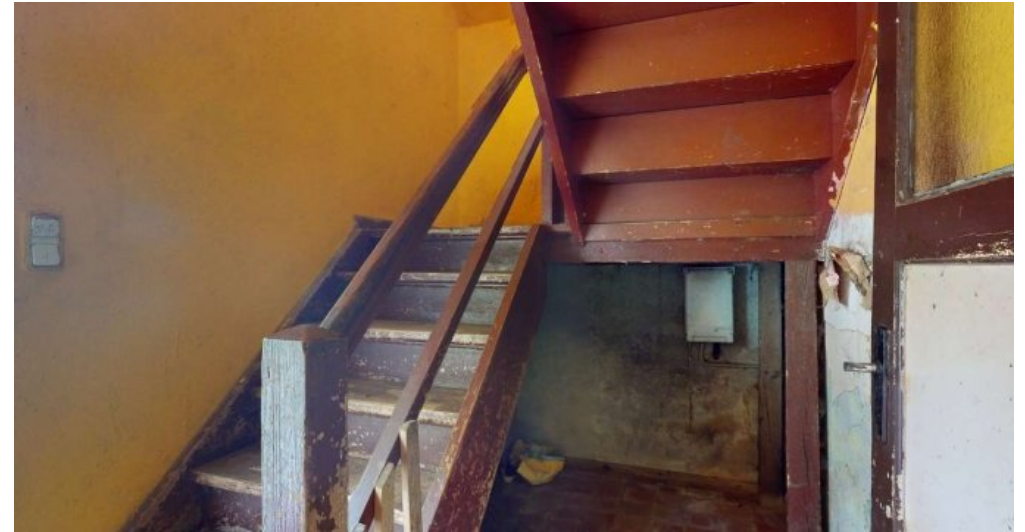
Treppe ins OG
