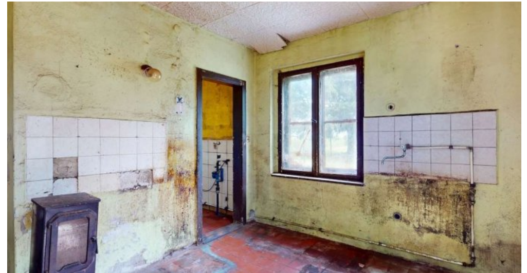
ehemalige Küche im EG
